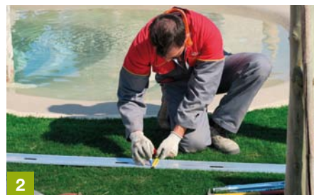
2 Misurazione lunghezza e segnatura per taglio a misura. Length measurement and cut to size marking.
