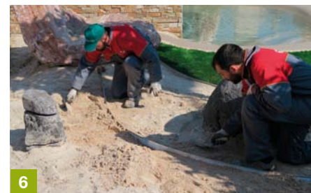
6 Compattazione del terreno vicino alla bordura. Ground compaction near the edging.
