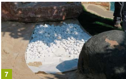
7 Stesura del telo in tessuto non tessuto di protezione. Protective non woven fabric laying.
