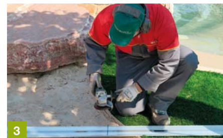
3 Taglio a misura con flessibile. Cut to size with a saw.
