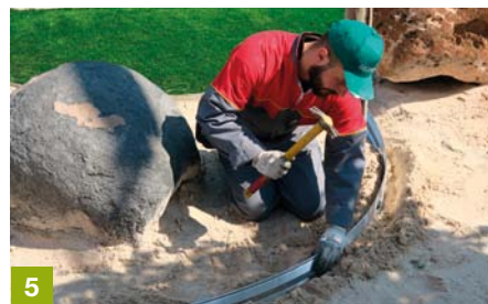
5 Ancoraggio al terreno con picchetti (solo per Alubord h14). Ground anchoring with pickets (Alubord h14 only).
